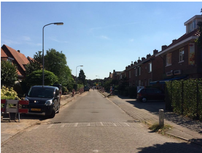
Kamperfoelielaan na kaalslag.
